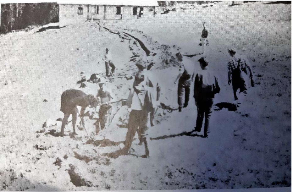
„Das Strom kommt“ – Aushub des Grabens für das Erdkabel 1966
